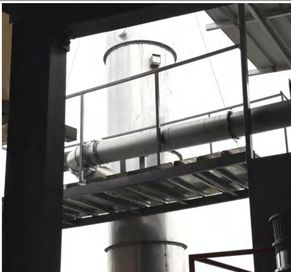
废气排口监测断面、监测孔
